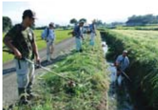
掘揚溝草刈・土砂浚渫作業
