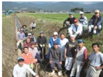
排水路のしゅんせつ作業
