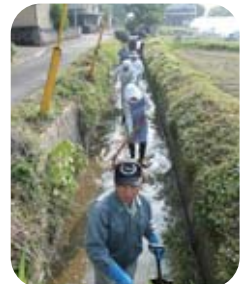
用水路のしゅんせつ作業
