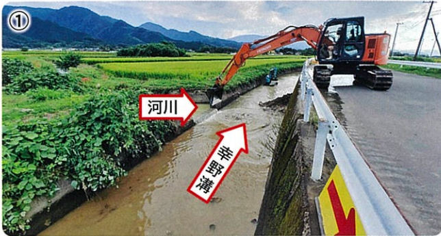
①【湯前町瀬戸口地区 多良木天満宮付近】 土砂約145m 3 が幸野溝へ流入
