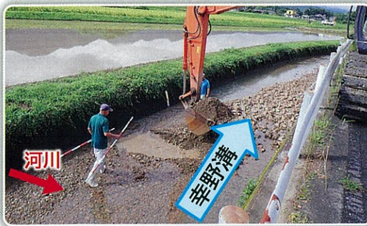
【湯前町瀬戸口地区 多良木天満宮付近】 土砂約90m 3 が幸野溝へ流入
