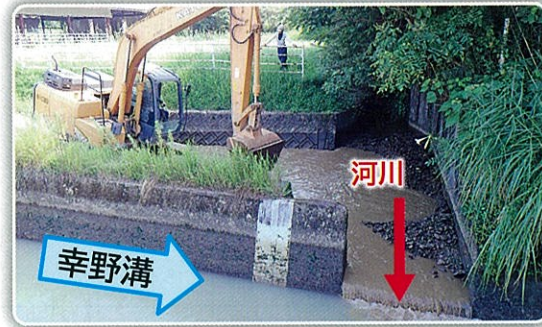
【多良木町奥野地区 中山観音付近】 土砂約60m 3 が幸野溝へ流入
